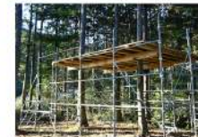
ツリーハウスのデッキまで完成
